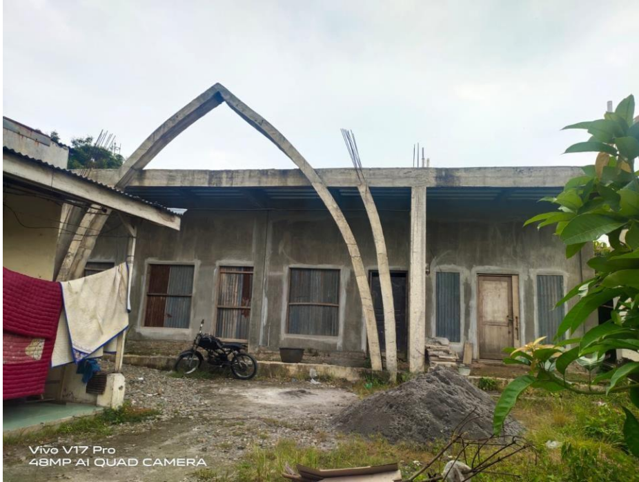
Gambar 4: keadaan rumah tahfidz masih dlam tahap pembangunan 4
