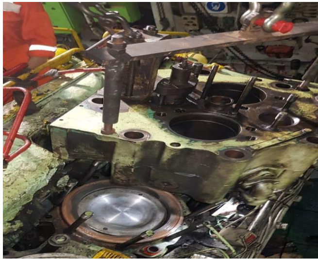
Gambar 4.8 Pembongkaran Cylinder Head
