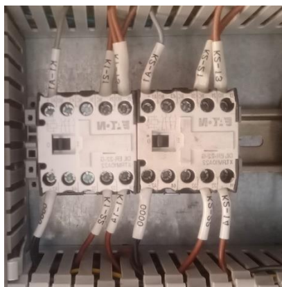
Gambar 2. 26 Kontaktor magnet 24 v
