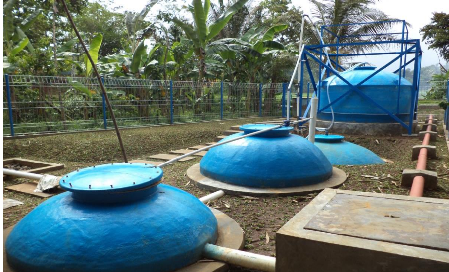
Gambar 2.6 Kubah Gas tetap
