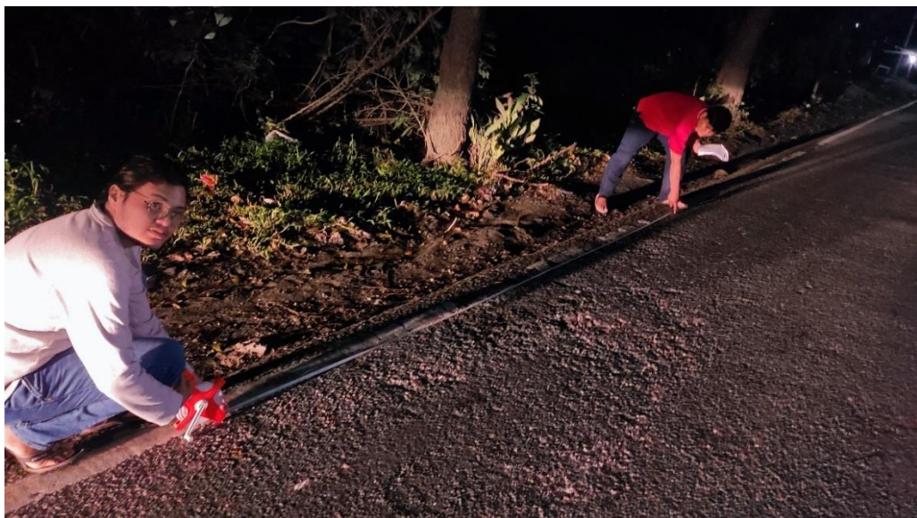
Gambar L.4: Foto Pengambilan Data Kerusakan
