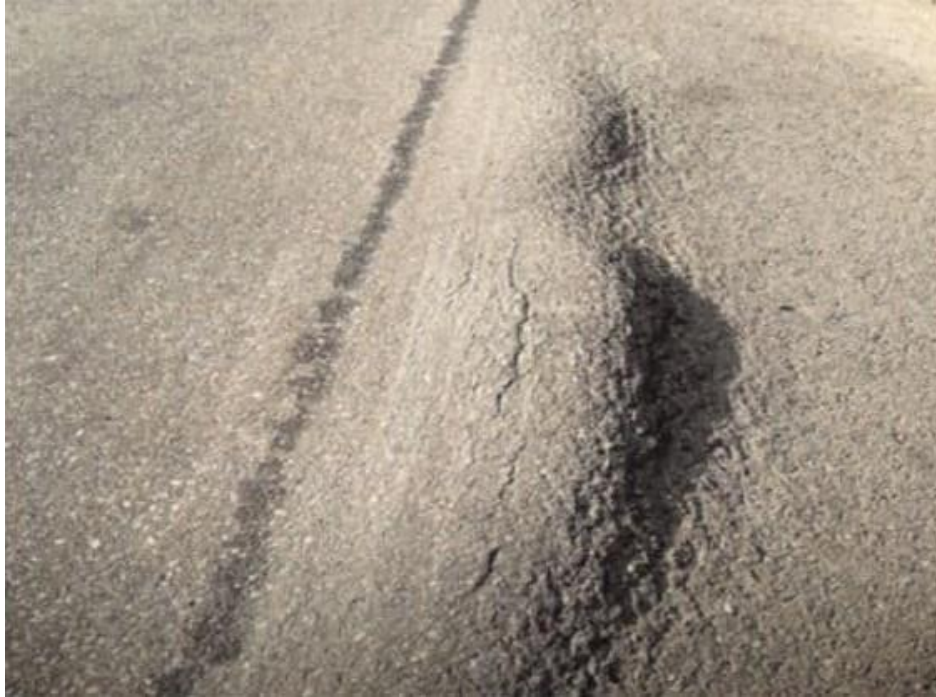
Gambar 4.2: Tonjolan dan turunan (Hasil Survei dilapangan)
