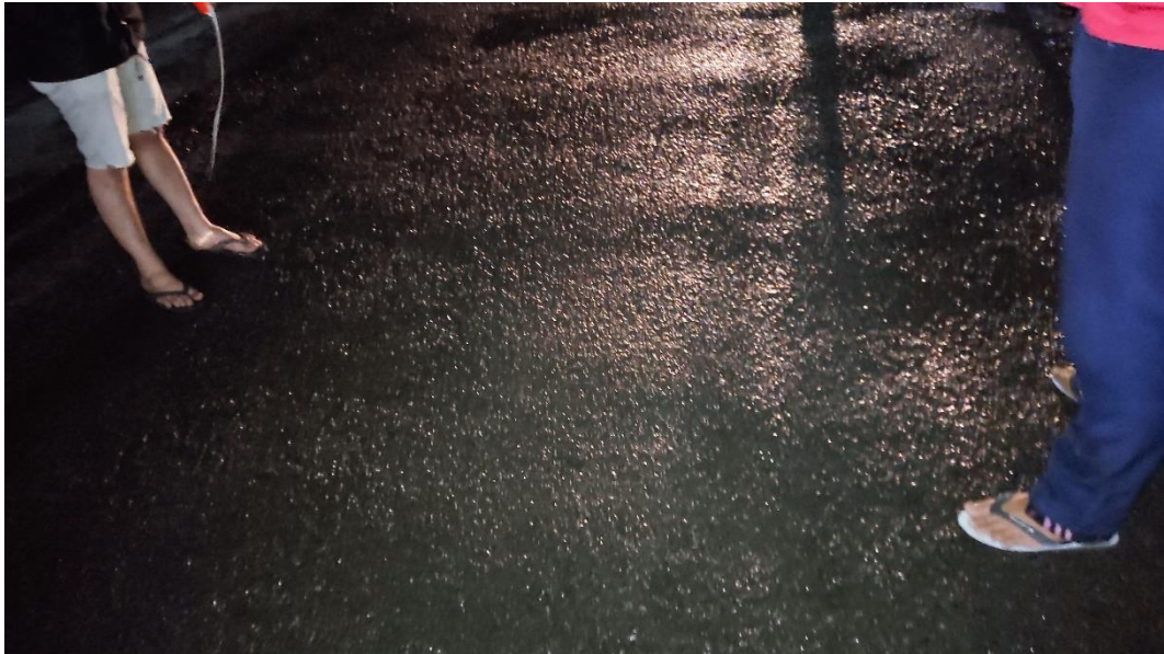
Gambar 4.8: Pelepasan dan Pelapukan (Hasil Survei)
