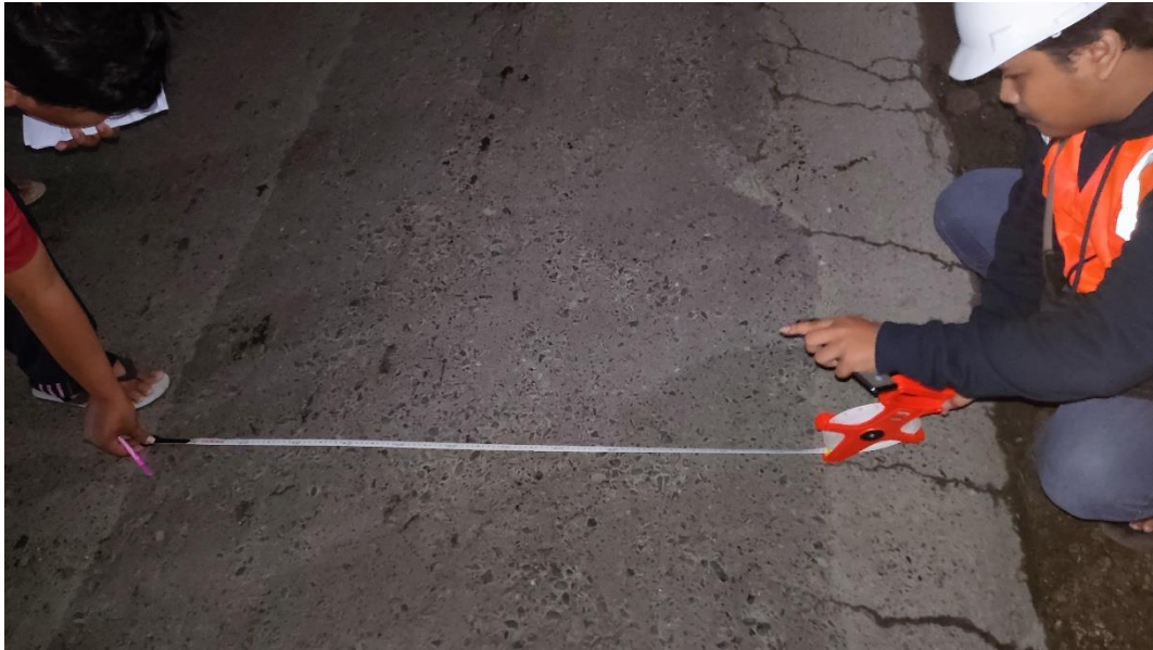
Gambar L.3: Foto Pengambilan Data Kerusakan
