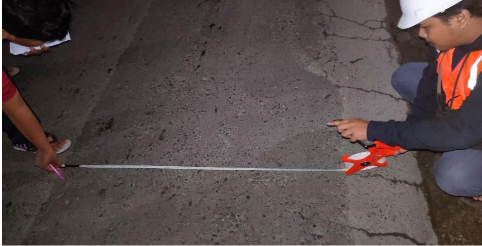
Gambar 4.6: Tambalan (Hasil Survei dilapangan)
