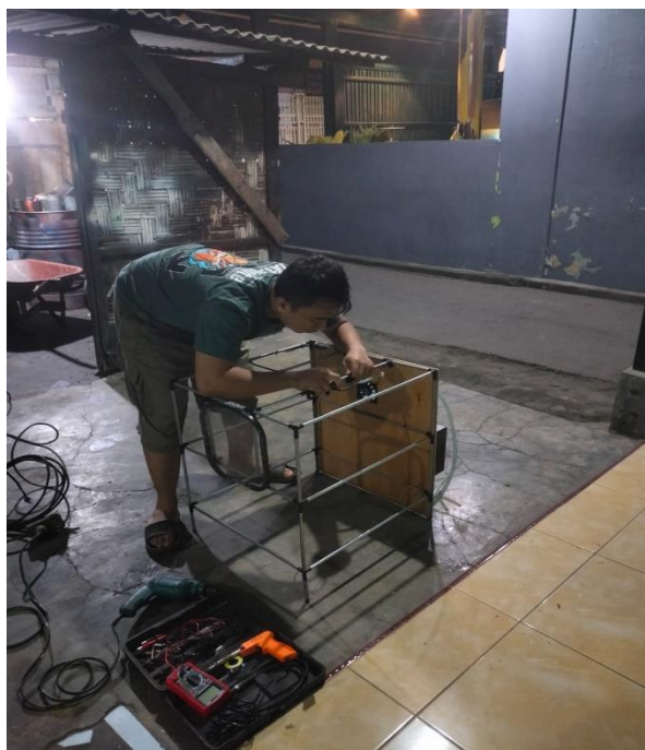
Gambar 4. 3 Pemasangan Pompa , Selang Dan Seprayer
