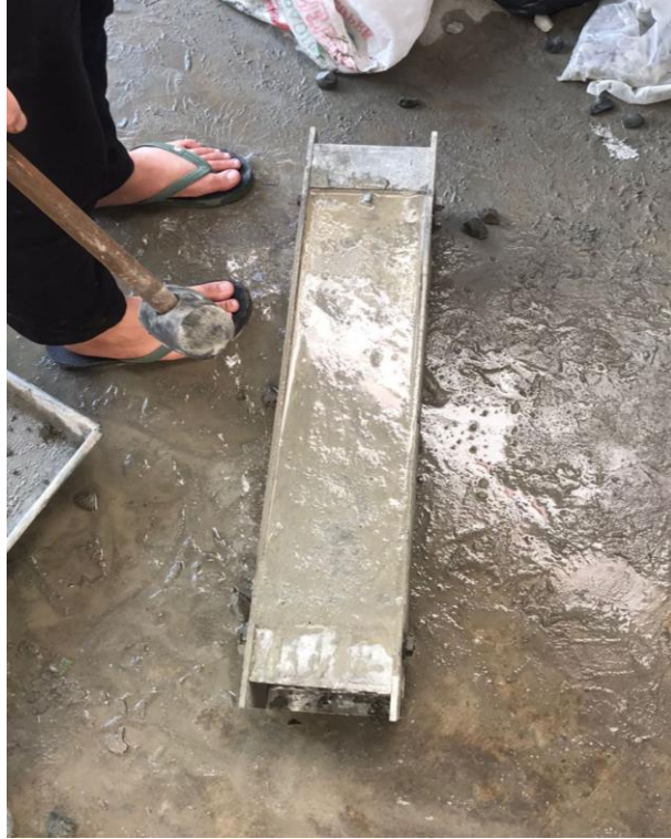
Gambar L.15 : Pencetakan Beton Balok
