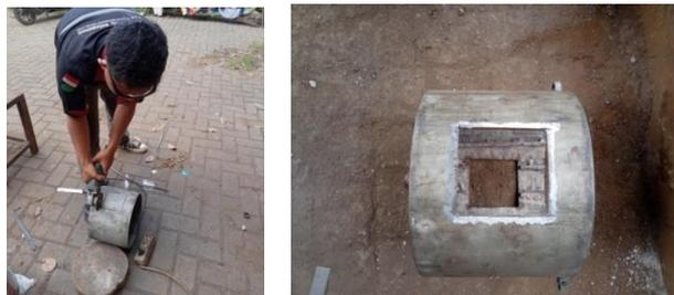
Gambar 4.19 Proses pemotongan lubang masuk dan lubang keluar pada pipa
