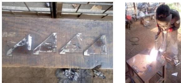
Gambar 4.15 proses pengelasan dudukan ruang penggiling
