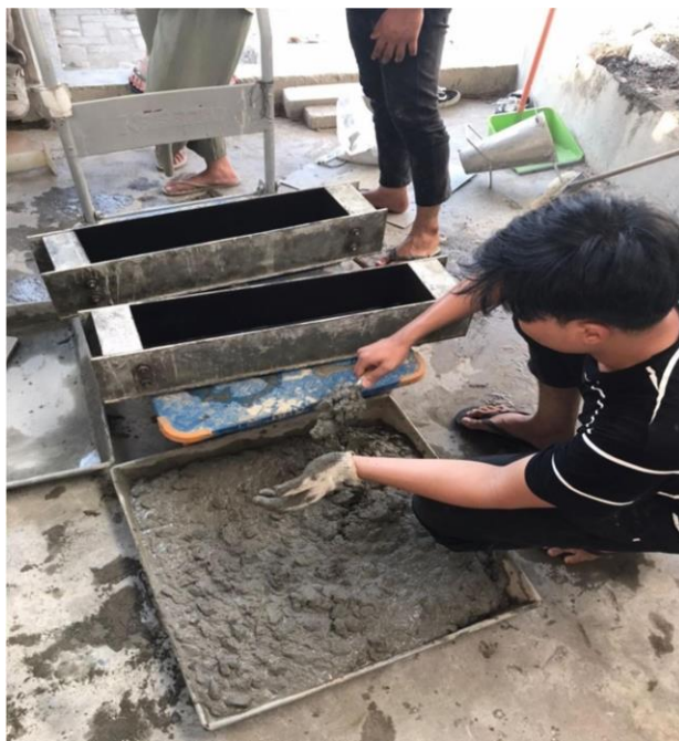
Gambar L.9 : Beton segar dimasukkan ke dalam bekisting
