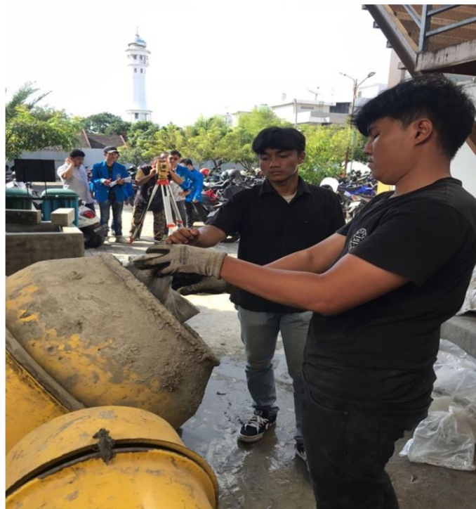
Gambar L.6 : Proses pembuatan beton
