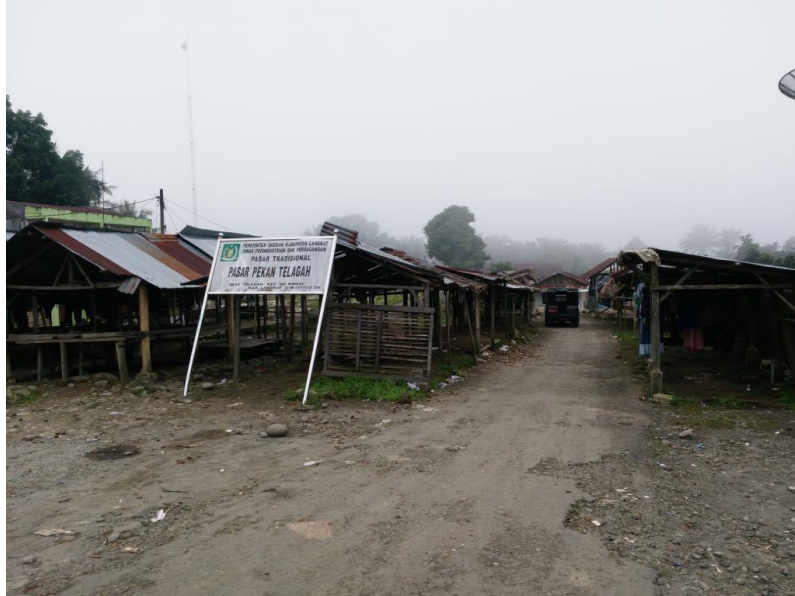
Lampiran 1: Tampak Depan Pasar Pekan Telagah
