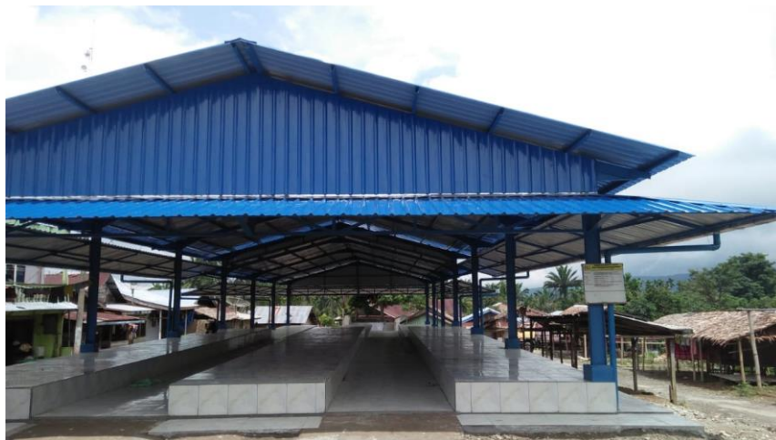
Gambar 3.6: Foto Pasar Pekan Telagah setelah di rehabilitasi.
