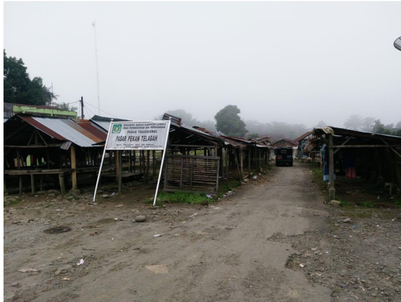
Gambar 3.5: Foto Pasar Pekan Telagah sebelum di rehabilitasi.
