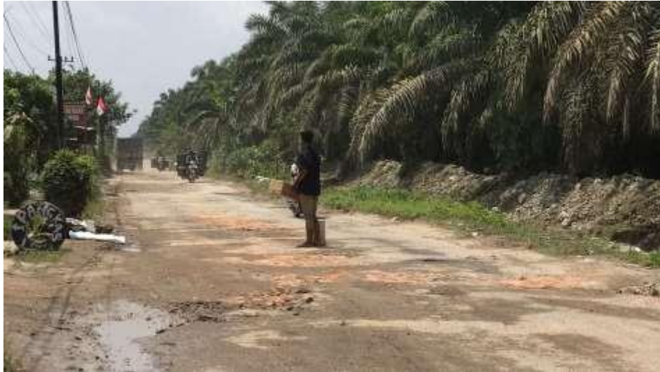
Pembangunan jalan cor
