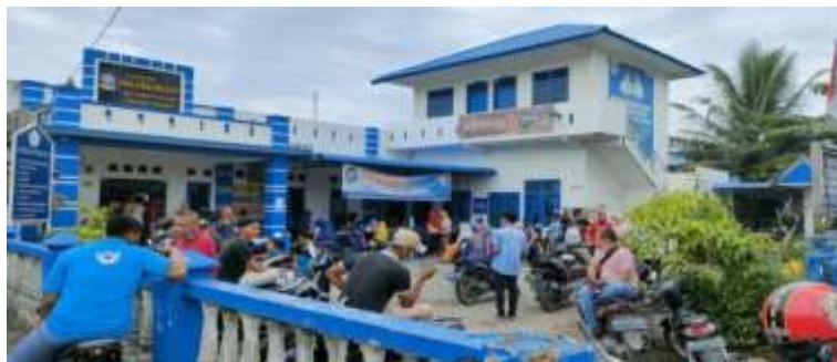
Tampak Depan Kantor Balai Desa Bandar Setia
