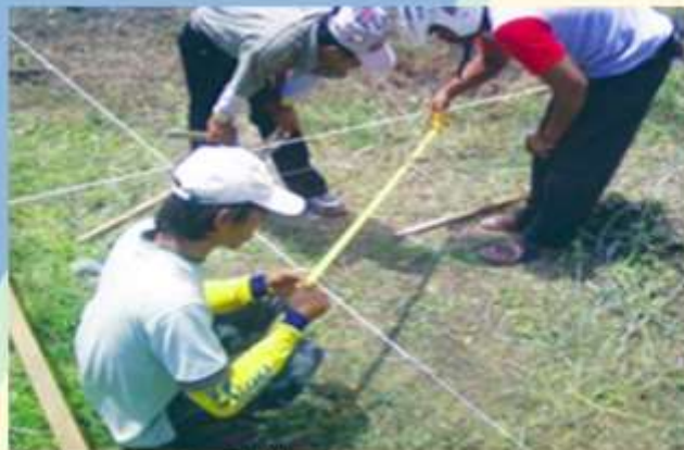
Gambar 1. Seorang tukang sedang mengukur kesikuan lahan
