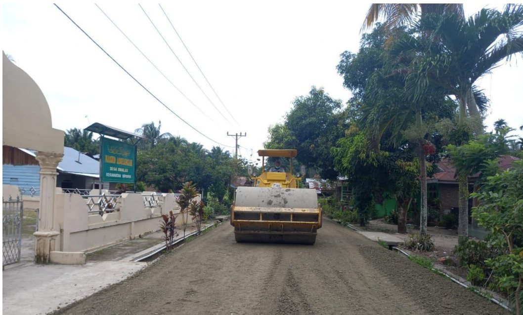
Gambar Lamp 4: Foto Lokasi Pekerjaan Peningkatan Ruas Jalan Simalas
