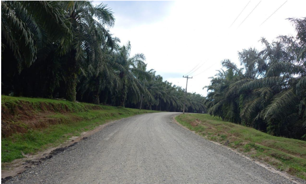
Gambar Lamp 7: Foto Lokasi Pekerjaan Peningkatan Ruas Jalan Simalas
