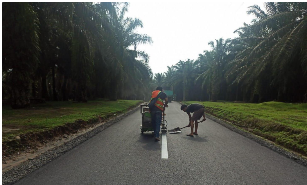
Gambar Lamp 8: Foto Lokasi Pekerjaan Peningkatan Ruas Jalan Simalas
