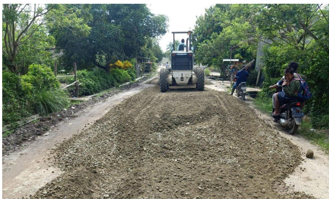
Gambar Lamp 2: Foto Lokasi Pekerjaan Peningkatan Ruas Jalan Simlas
