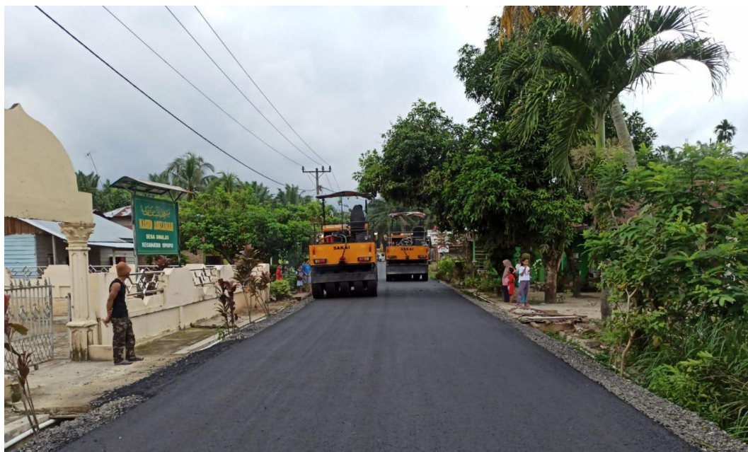
Gambar Lamp 6: Foto Lokasi Pekerjaan Peningkatan Ruas Jalan Simalas
