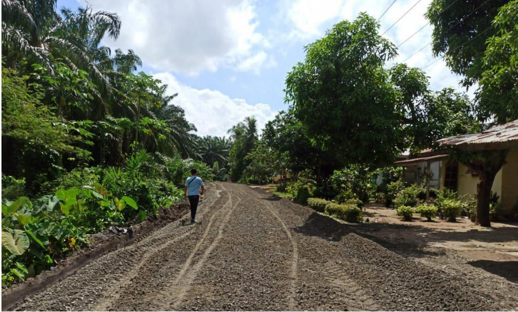
Gambar Lamp 3: Foto Lokasi Pekerjaan Peningkatan Ruas Jalan Simalas
