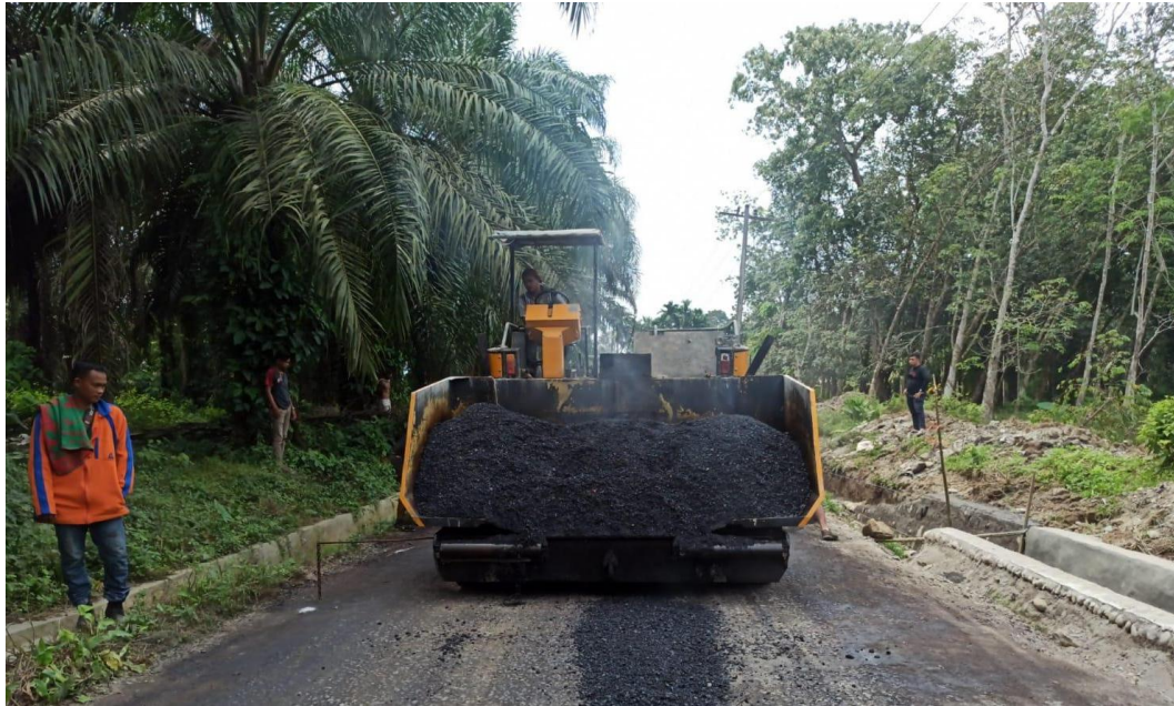
Gambar Lamp 5: Foto Lokasi Pekerjaan Peningkatan Ruas Jalan Simalas
