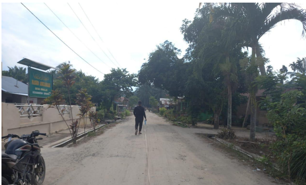
Gambar Lamp 1: Foto Lokasi Pekerjaan Peningkatan Ruas Jalan Simlas
