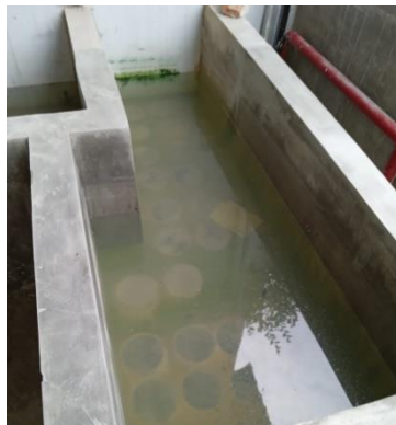
Gambar 3.13 Perawatan Beton
