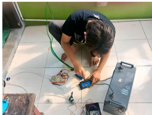
Proses Penyambungan Instalasi PLTS
