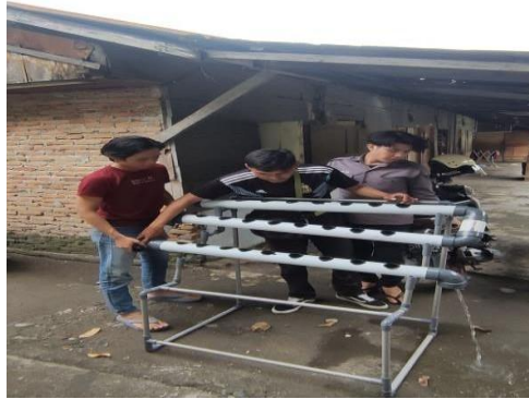
Proses Pemasangan Pipa Yang Sudah Dilubangi
