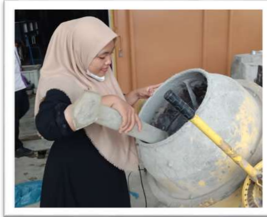
Gambar L-1: Pembuatan Campuran Beton dengan Mixer
