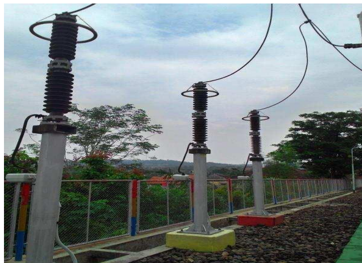
Gambar 2.9 Arrester Pada Gardu Induk Binjai
