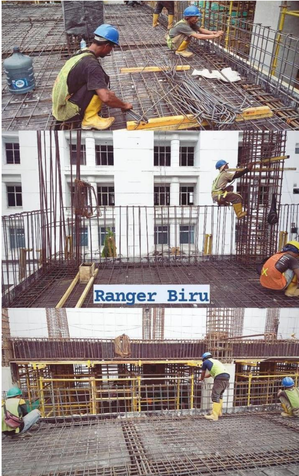
L3: Installasi Besi Pagar dan Kolom
