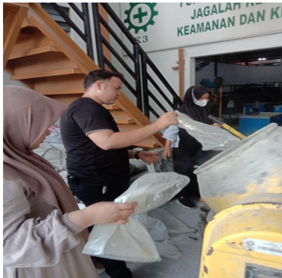
Lampiran 26: Proses pembuatan adukan beton.
