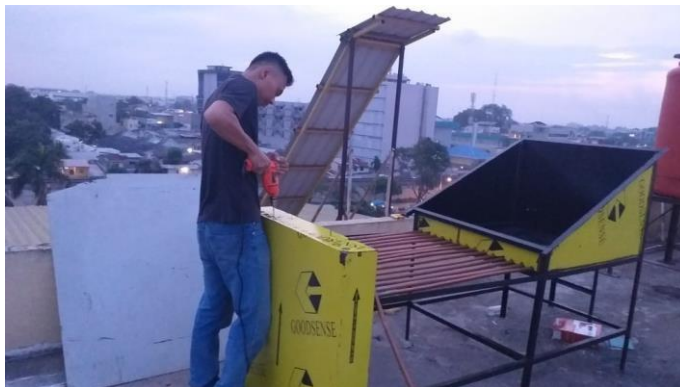
Tahap pemasangan penyerap pipa tembaga pada kolektor
