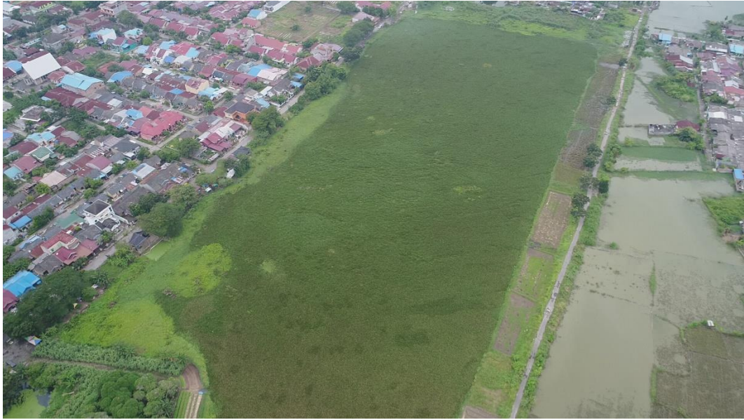
Gambar L.1: Kolam retensi dari pengambilan drone.
