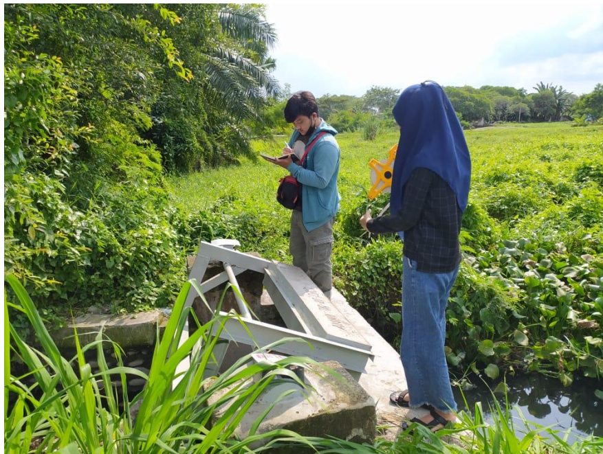
Gambar L.6: Pintu Outlate Kolam Retensi.
