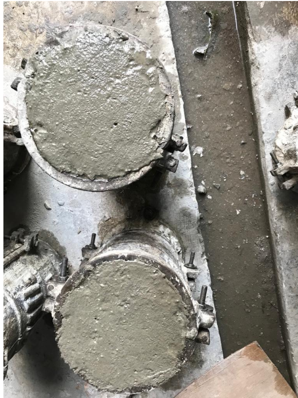
L.6 : Beton segar di masukkan kedalam bekisting
