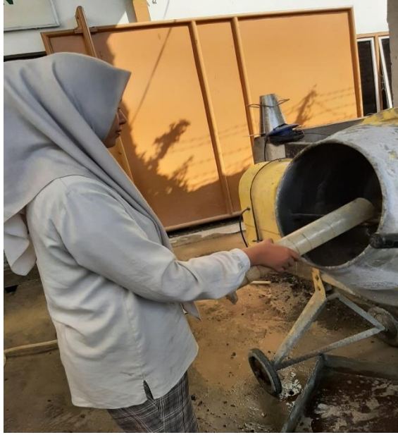
Gambar L.4: Proses pembuatan beton dengan mixer
