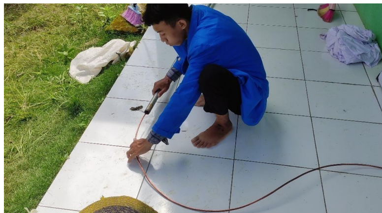
Gambar 3. Proses Pemasukan Kabel BC 50mm Ke Pipa Galvanis
