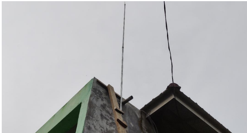
Gambar 5. Pemasangan Air Termination
