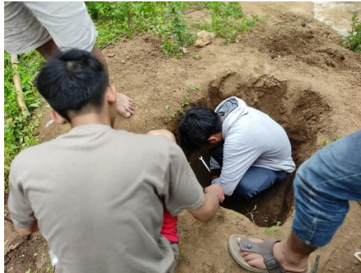
Gambar 1. Penggalian Lubang Untuk Elektroda Mesh
