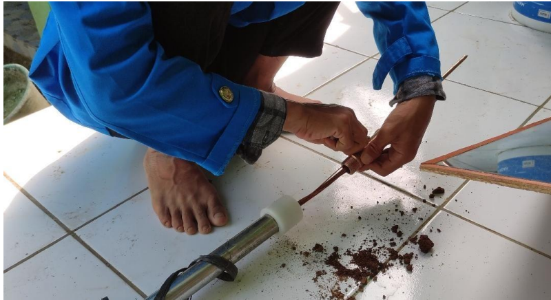
Gambar 4. Proses Penyambungan Kabel BC ke Tombak Split
