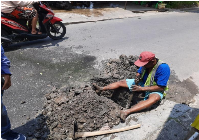
Dilakukannya penggalian untuk memperbaiki pipa yang bocor
