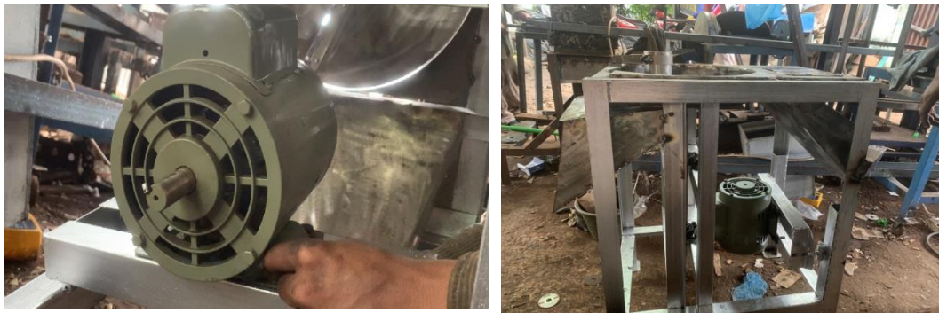
Gambar 4.2. Pemasangan Sistem Transmisi
