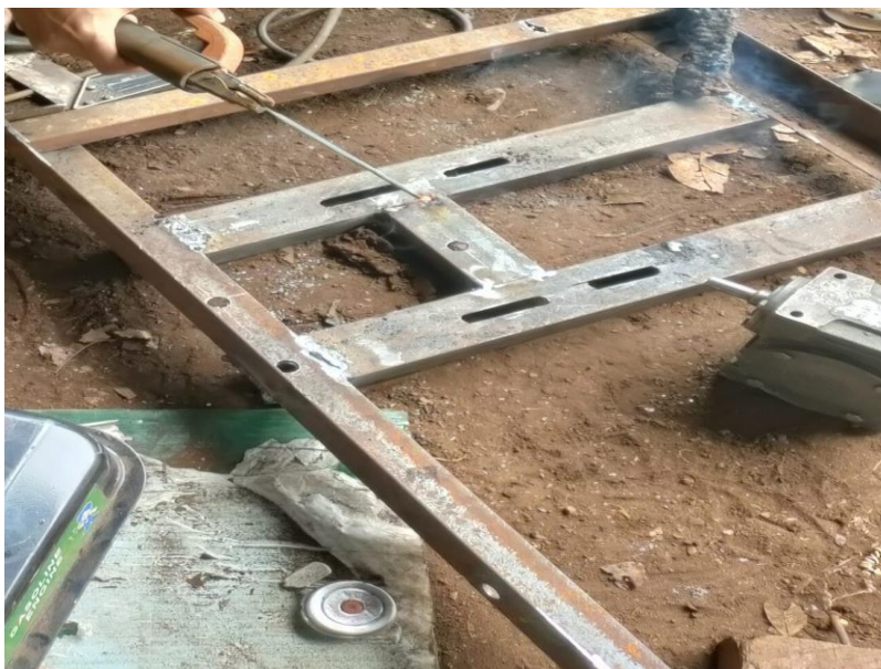
Gambar 4.6 pembuatan dudukan mesin
