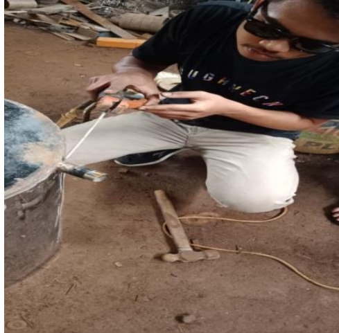
Gambar 4.33. Proses Pengelasan Pipa Pada Tabung
