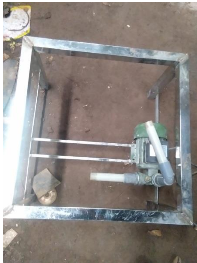
Gambar 4.64. Pemasangan Pompa Pada Dudukan
