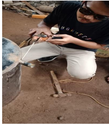
Gambar 4.18. Proses Pengelasan Pipa Stainless Steel Pada Pabung
