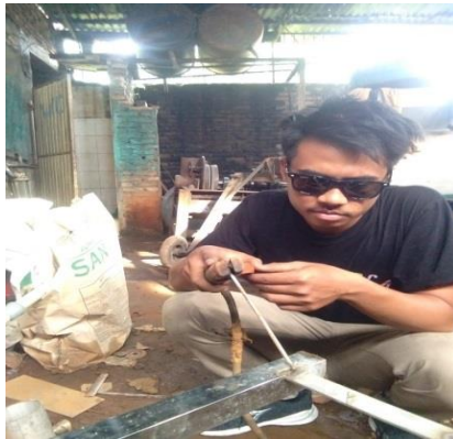
Gambar 4.49. Proses Pengelasan Plat Pada Kakian Dudukan
