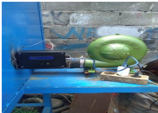
Gambar 4.7 Hasil Pemasangan Box arduiuno dan blower keong
