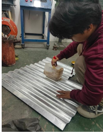
Gambar 3.20 Melapisi resin pada permukaan atap
