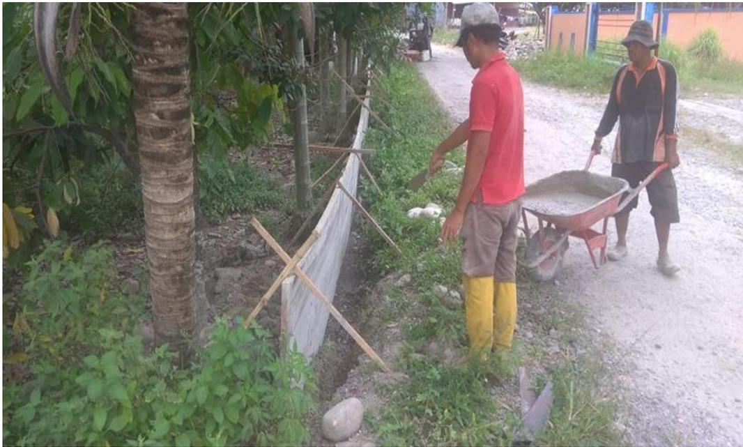
Gambar L.1: Dasar galian dibuat rata dan diberi landasan dari adukan semen dengan pasir setebal minimal 3 cm sebelum meletakkan batu
