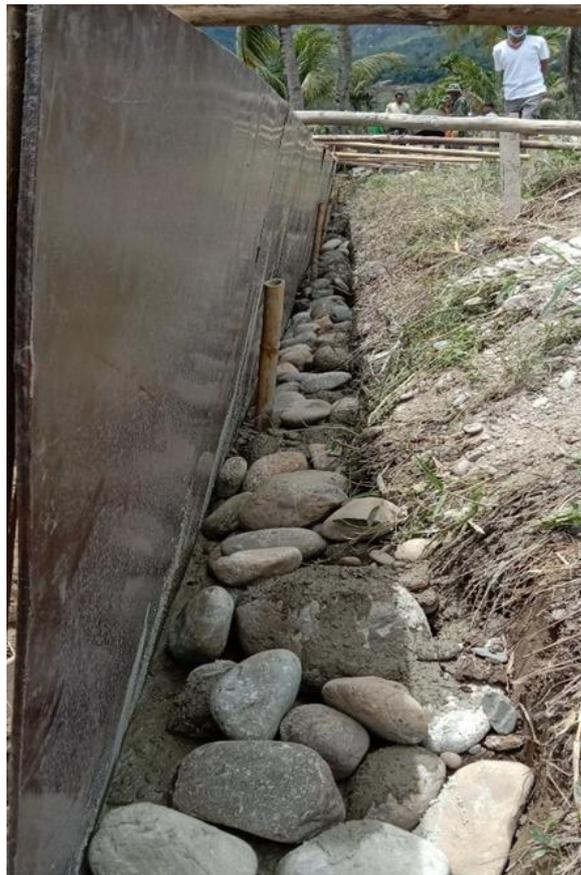
Gambar L. 4: Batu dengan ukuran yang besar diletakkan pada lapisan dasar
