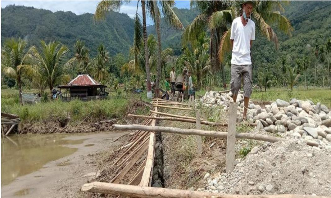
Gambar L.3: Batu dengan ukuran yang besar diletakkan pada lapisan dasar
