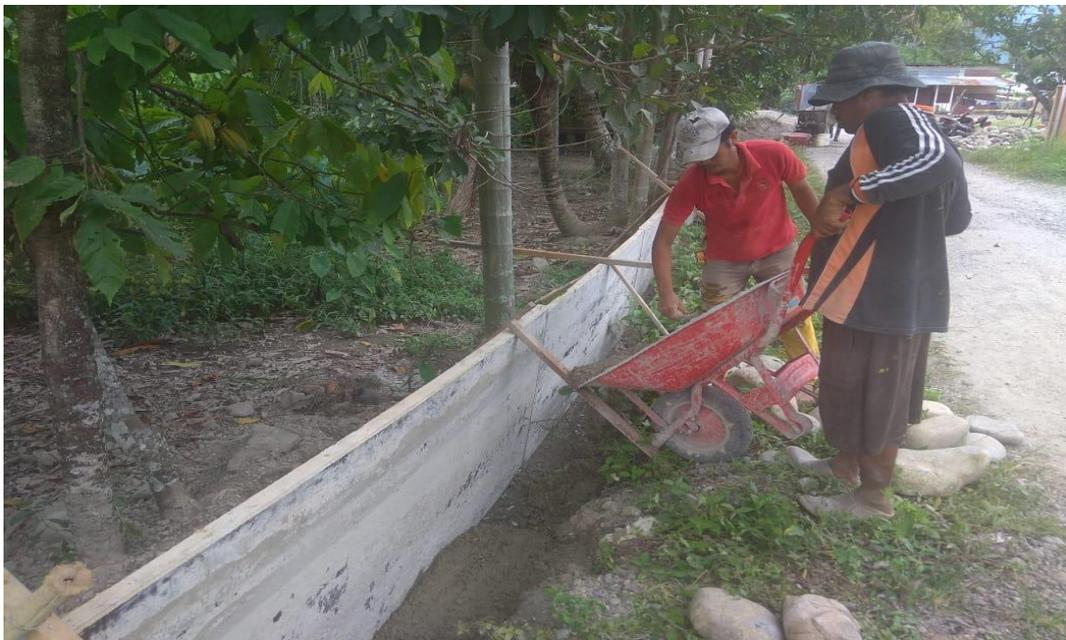
Gambar L.2: Dasar galian dibuat rata dan diberi landasan dari adukan semen dengan pasir setebal minimal 3 cm sebelum meletakkan batu
