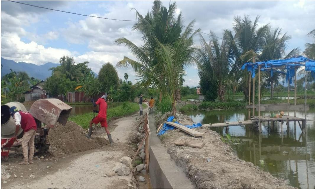
Gambar L.5: Pekerja menyiapkan bahan adukan atau mortar menggunakan alat molen
