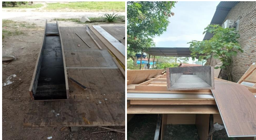
Gambar 4.14 Proses Perakitan Saluran Segiempat
