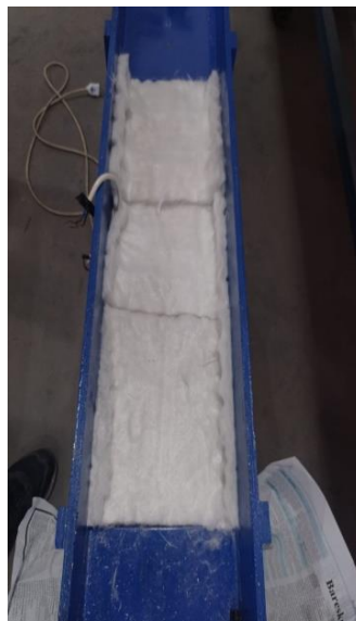
Gambar 4.24. Pemasangan Busa Tahan Panas
