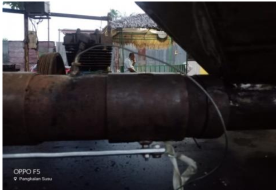
Gambar 3.33 Proses Pemasangan Sensor
