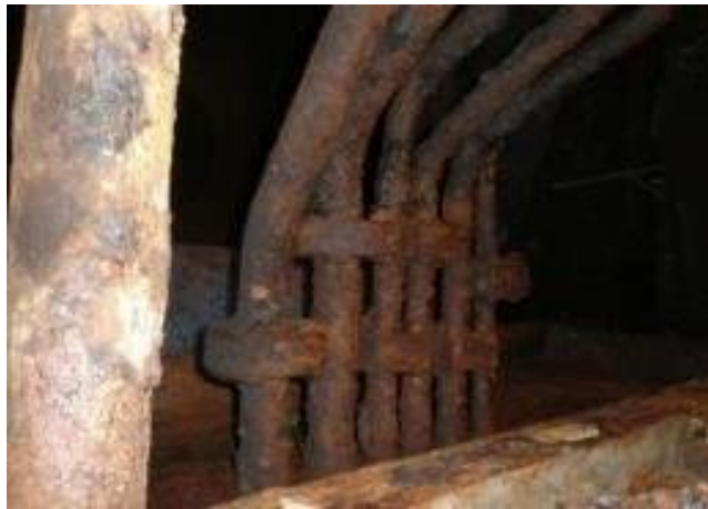
Gambar 2.1 Uniform Attack (Korosi Seragam) pada pipa ballast (Utomo, 2009)
