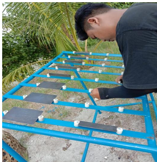
Foto peletakan spesimen awal
