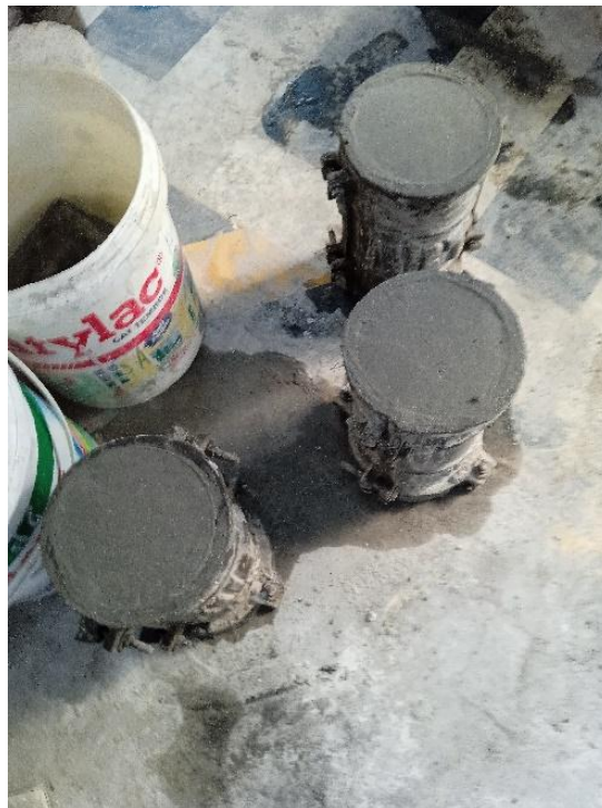
sPencetakkan beton silinder
