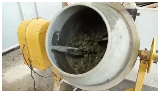
Lampiran 26 : Proses Pembuatan Adukan Beton
