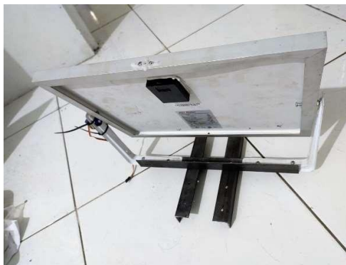
Gambar 3.6. Pemasangan panel PV pada besi penyangga
