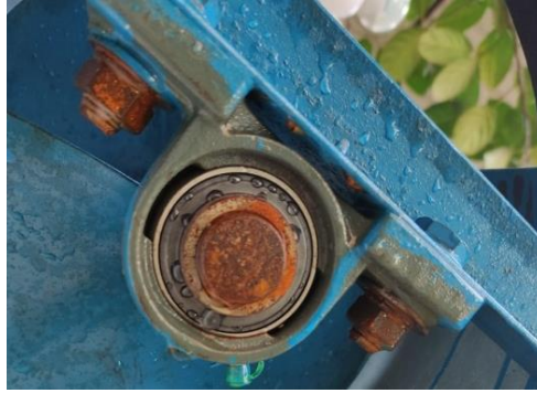
Gambar 4.46 Pemasangan Pillowblock bearing
