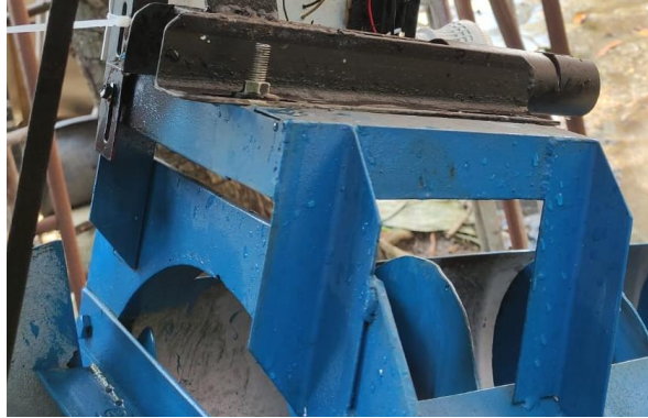
Gambar 3.41 Hasil Pembuatan Dudukan Generator
