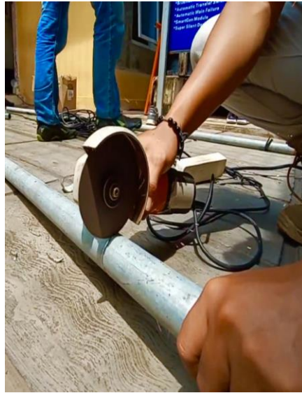
Gambar 4.19 Pemotongan Besi Pipa
