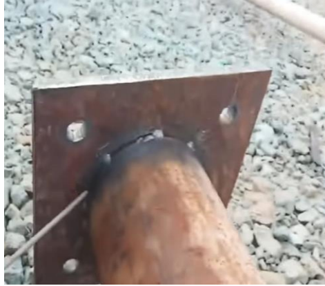
Gambar 4.31 Pengelasan Penampungan air.
