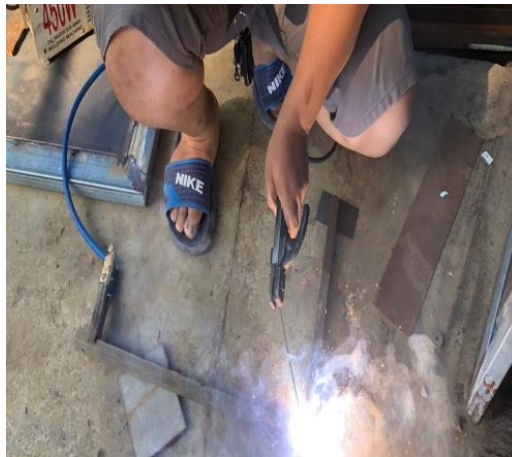
Gambar 4.27 Membuat Dudukan Generator.
