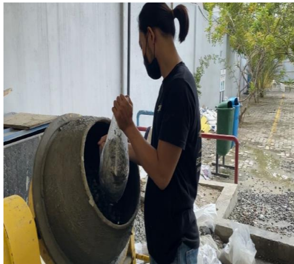
Gambar L-16 Proses Pembuatan Adukan Beton
