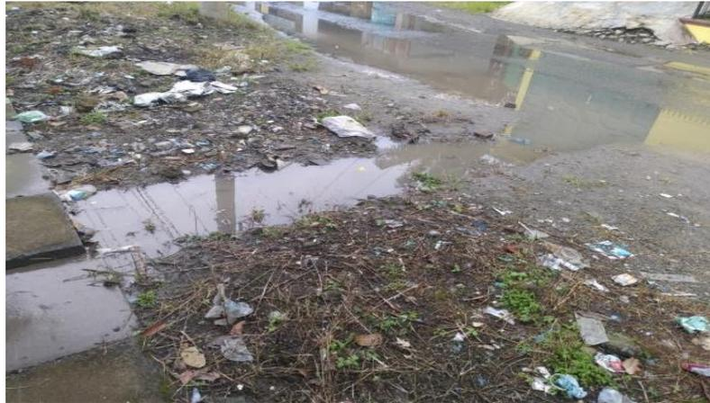
Gambar 4.26: Saluran *street inlet* buatan yang tersumbat
