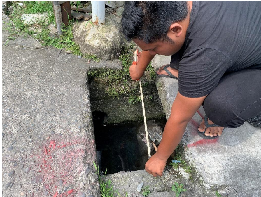
Foto 2. Pengukuran Lebar Drainase
