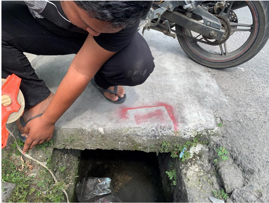
Foto 3. Mengukur ketinggian drainase
