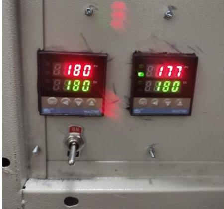
Gambar 3.21 Penyetelan suhu pada PID
