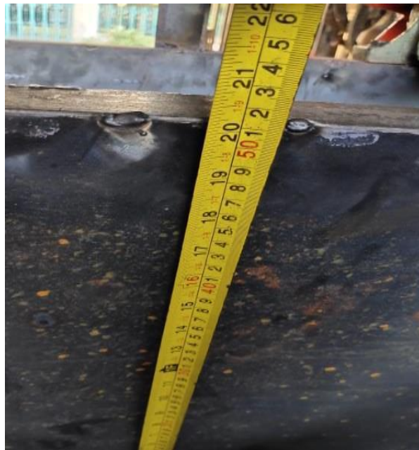
Gambar 4.3 Pengukuran besi hollow dan besi baja
