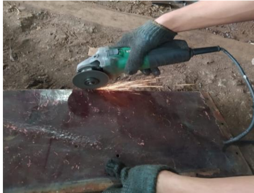
Gambar 4.14 Memotong Besi Plat dan Besi Hollow
