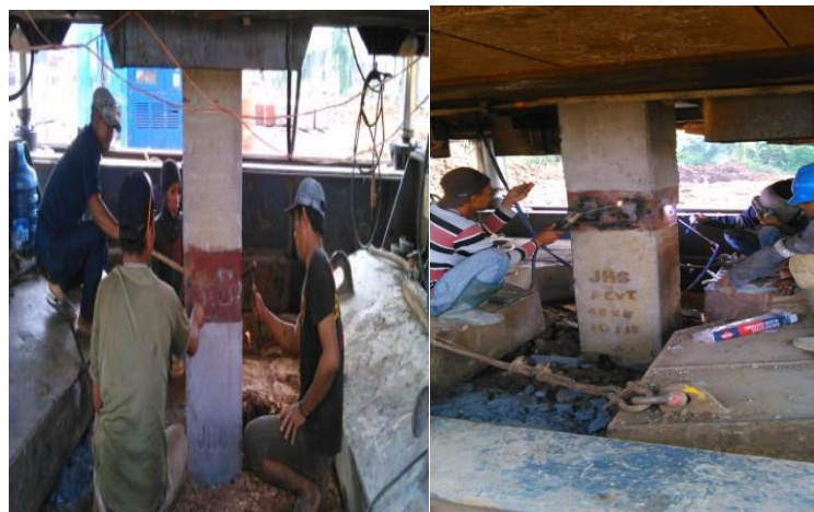
Gambar 2.6: Sambungan & Pengelasan.
