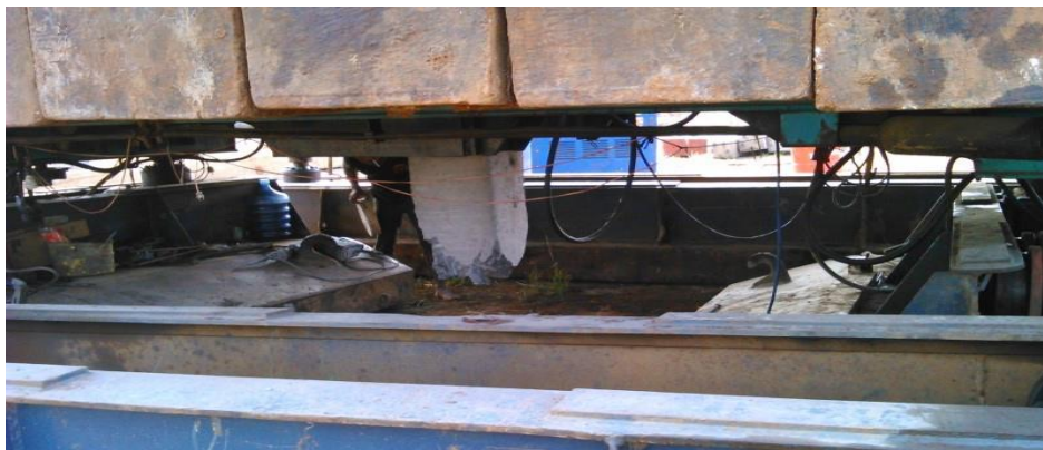
Gambar 2.9: Pengambilan Sisa Beton.
