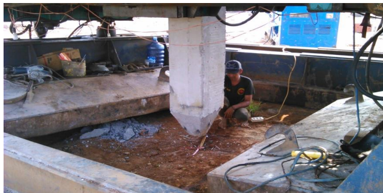
Gambar 2.3: Titik pancang yang di tentukan.
