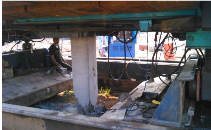
Gambar 2.8: Pemotongan sisa beton tiang pancang.
