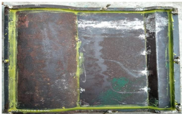
Gambar 3.39 Pemberian Plastisin Pada Cetakan Atap
