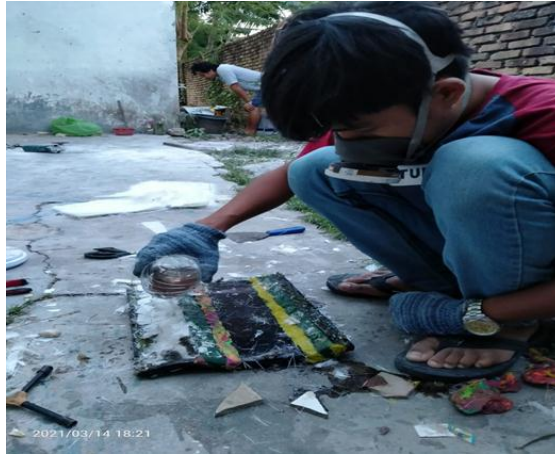
Gambar 3.44 Proses Penuangan Resin Setelah Penuangan fiberglass
