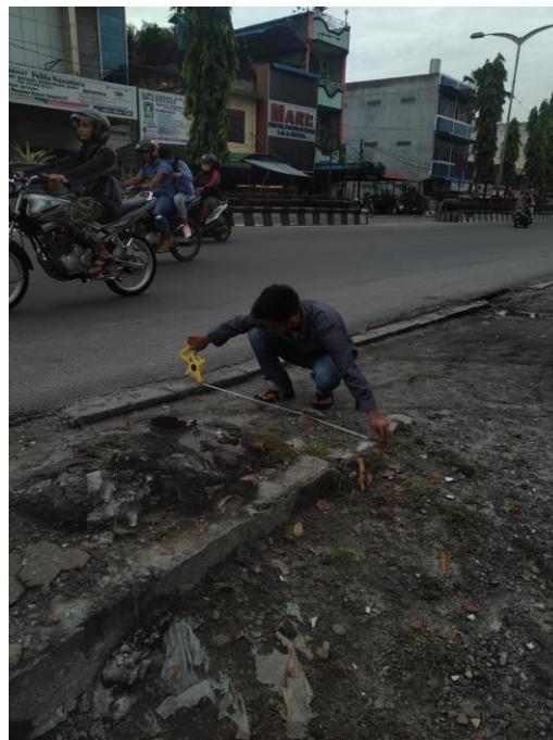
Gambar L.1: 4 Dokumentasi Mengukur Lebar bahu jalan
