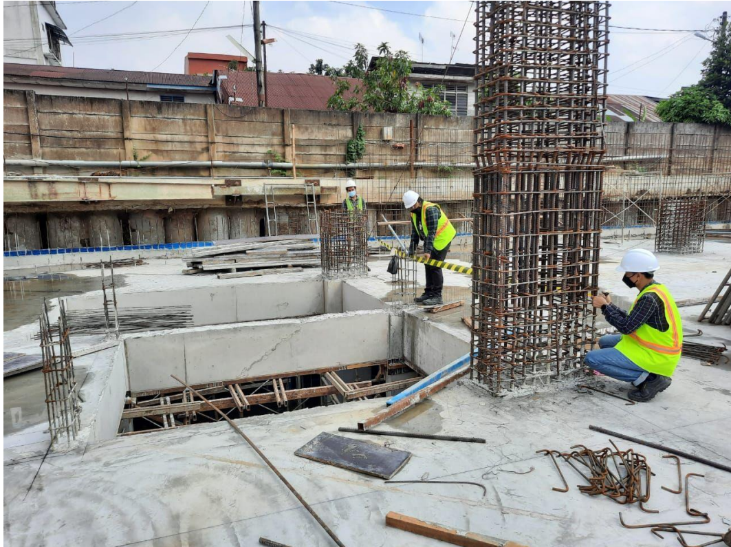
Gambar L3 : pengerjaan tulangan kolom.
