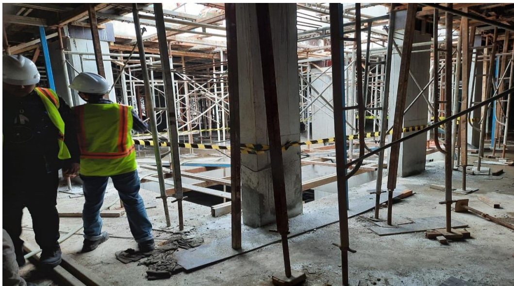
Gambar L2 : pengerjaan pemasangan perancah.
