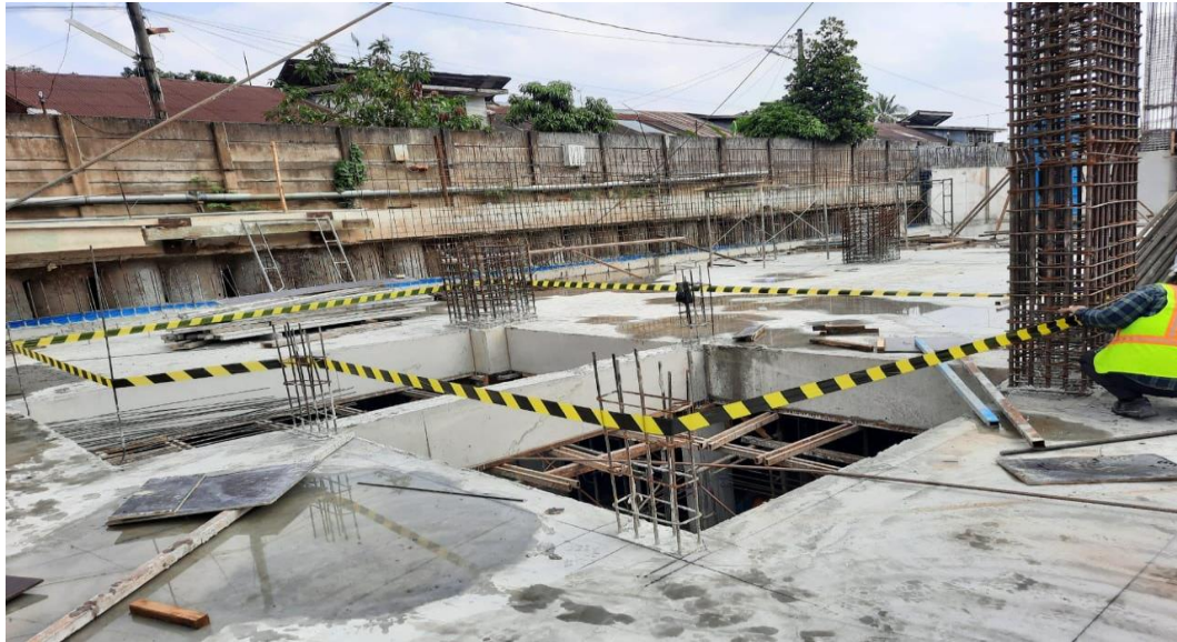
Gambar L1 : Setelah pekerjaan pengecoran.
