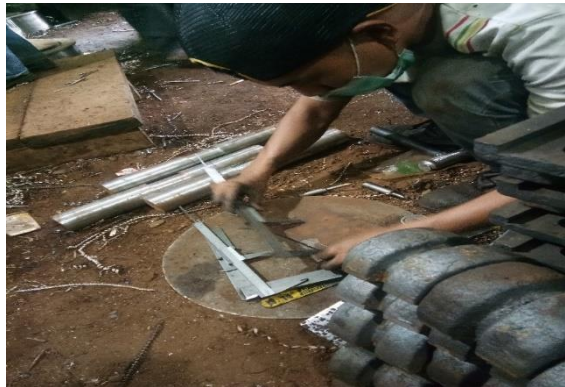
Gambar. 4.13. Pengukuran Besi Plat
