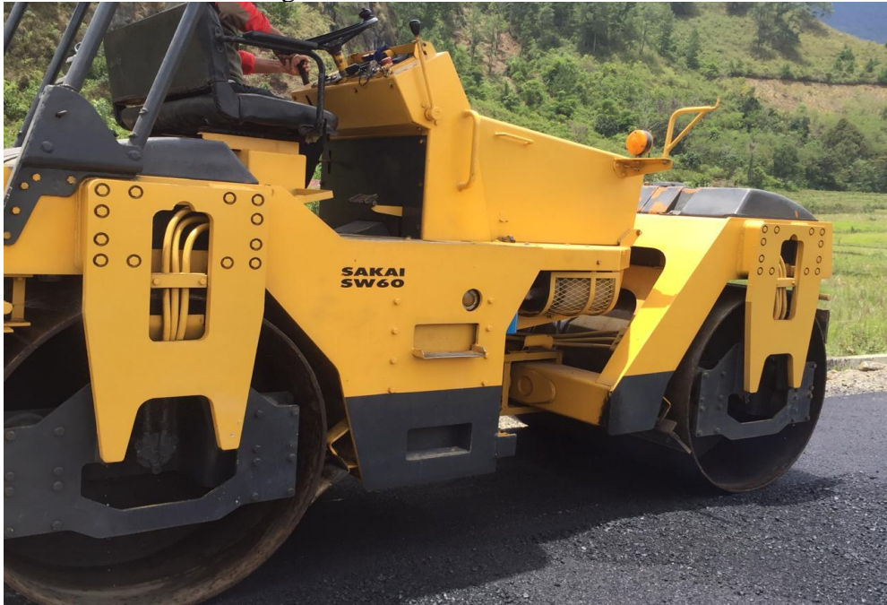
Gambar Lamp. 11: Foto Lokasi Pekerjaan Pembangunan Jalan Transmigrasi Teget.
