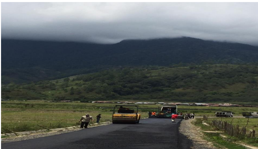
Gambar Lamp. 12: Foto Lokasi Pekerjaan Pembangunan Jalan Transmigrasi Teget.
