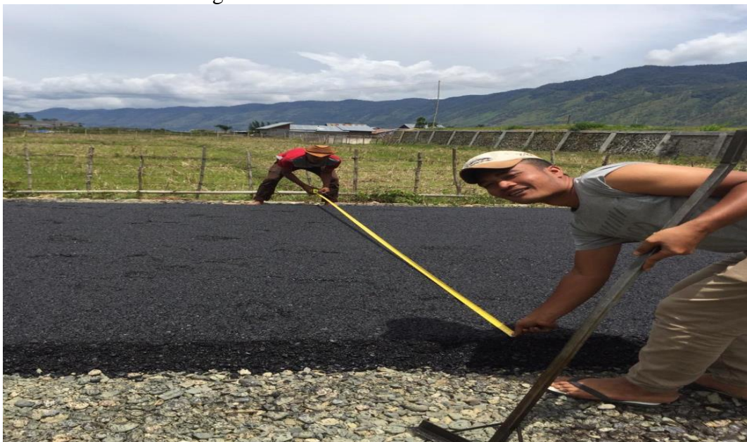
Gambar Lamp.10: Foto Lokasi Pekerjaan Pembangunan Jalan Transmigrasi Teget.
