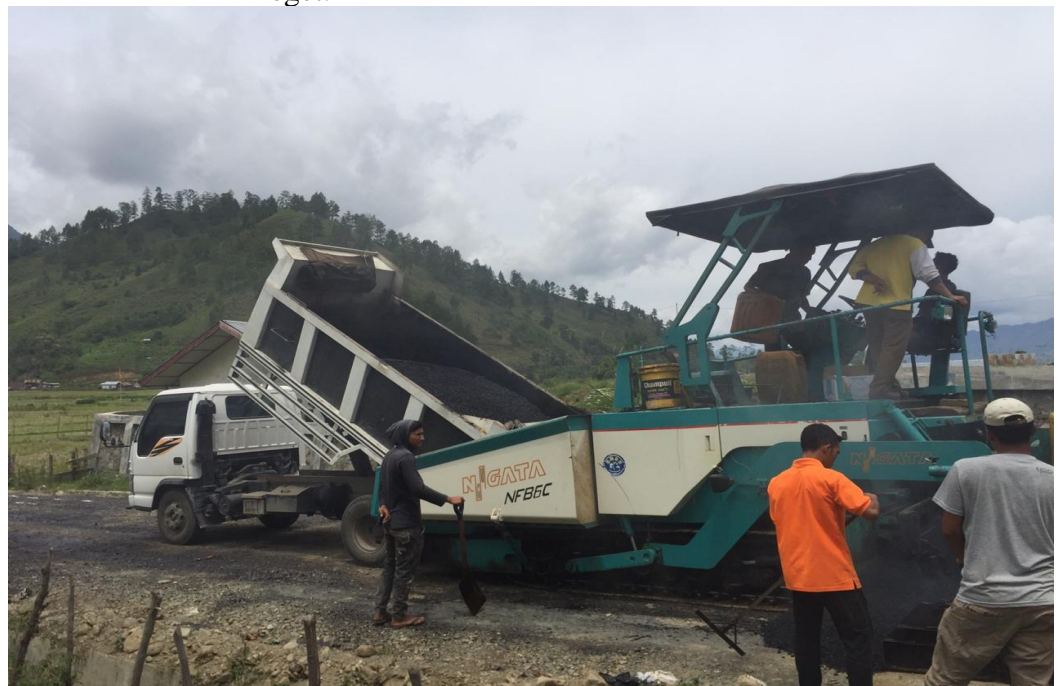
Gambar Lamp 6: Foto Lokasi Pekerjaan Pembangunan Jalan Transmigrasi Teget.
