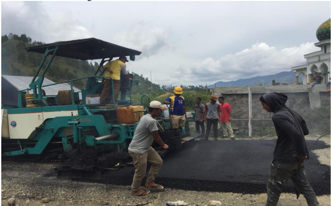
Gambar Lamp 8: Foto Lokasi Pekerjaan Pembangunan Jalan Transmigrasi Teget.
